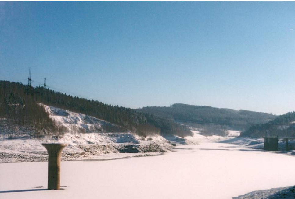
Überlauftrumpete & Einlass im Winter
