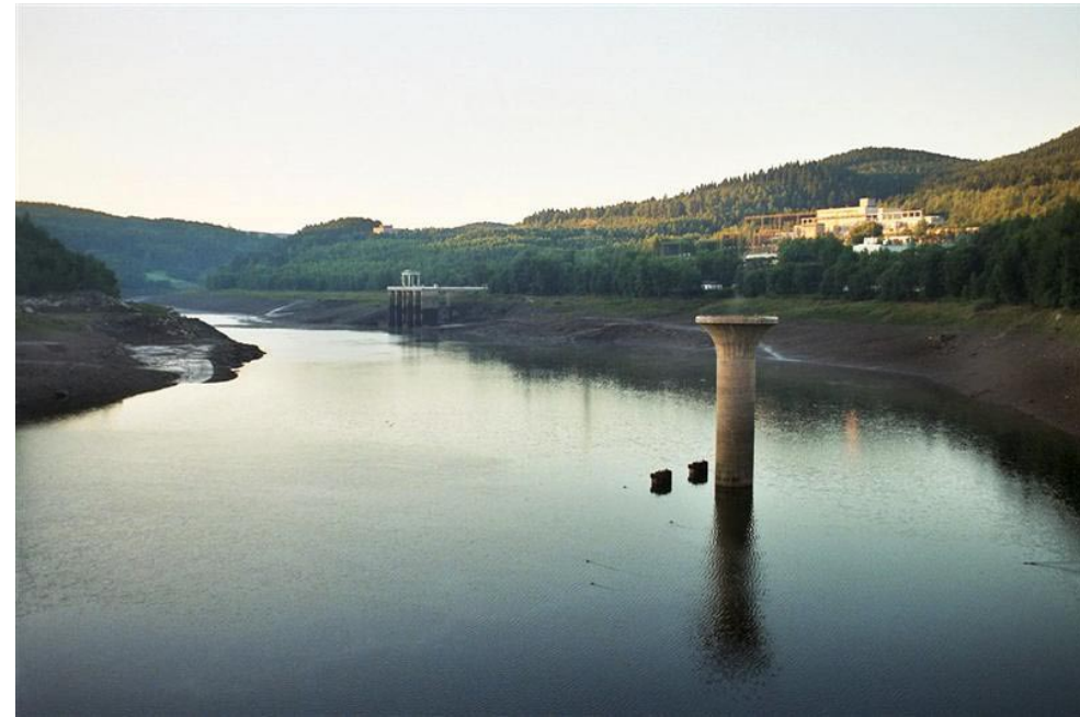
Einlass, Überlauftrumpete, Stromwerk
